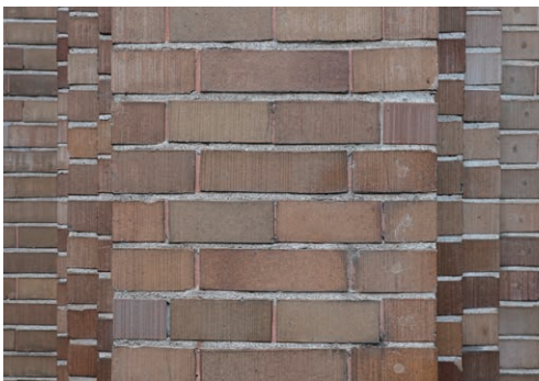
縦筋模様が入った茶褐色のタイル貼り (外壁)
